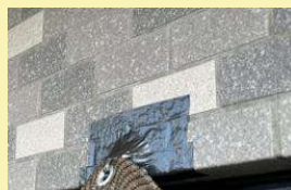
タイルの補修に！
