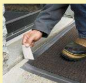
フロアシートの仮固定に
