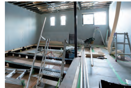
工事・建設現場
