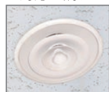
天井吹き出し口 (丸) (直径 500~830mm)
