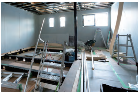
工事・建設現場
