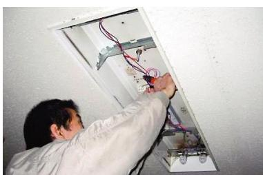
(電子安定器への交換作業)
